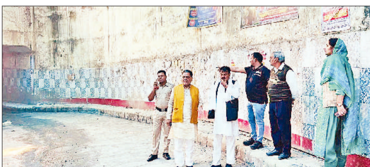
बहादुरगढ़। अंडरपास में मरम्मत कार्य का निरीक्षण करती चेयरपर्सन सरोज राठी। फोटो: हरिभूमि
